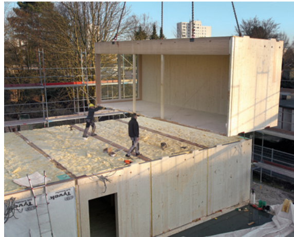
Montage der vorgefertigten Module bei der Europäischen Schule in Frankfurt, Architekten NKBAK
