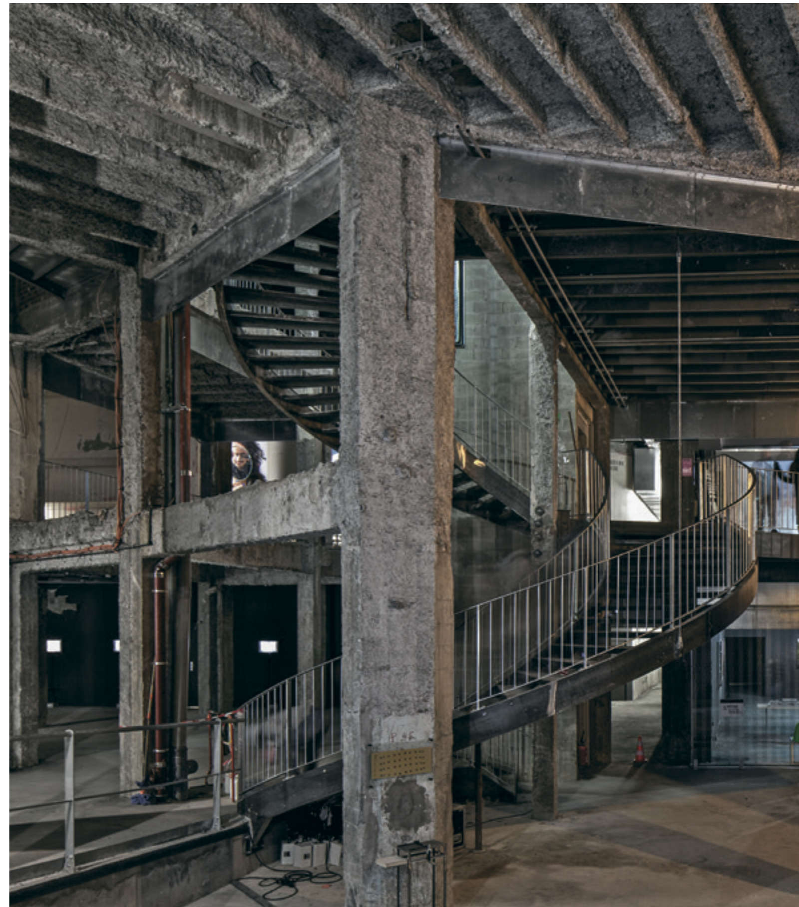
Lacaton & Vassal: Palais de Tokyo in Paris, 1. Phase 2002. Umbau des für die Pariser Weltausstellung 1937 errichteten Gebäudes in ein Ausstellungshaus für zeitgenössische Kunst.
